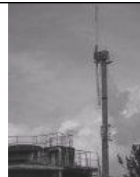
De Volhouder, Halsteren Sinds 1991 Lagerwey (75 kW) Wiekdiameter: 15 m Ashoogte: 30 m Jaaropbrengst: 56.100 kWh
