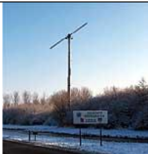
De Windvogel, Bodegraven Sinds 1994 Lagerwey (80 kW) Wiekdiameter: 18 m Ashoogte: 80 m Verwachte jaaropbrengst: 80.000 kWh
