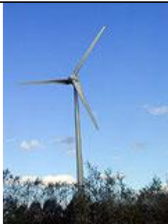
De Amstelveugel, Ouderkerk aan de Amstel Sinds 2005 Enercon (2000 kW) Wiekdiameter: 71 m Ashoogte: 85 m Hiervoor stond er 13 jaar een kleinere Lagerwey-turbine Verwachte jaaropbrengst: 4.091.175 kWh
