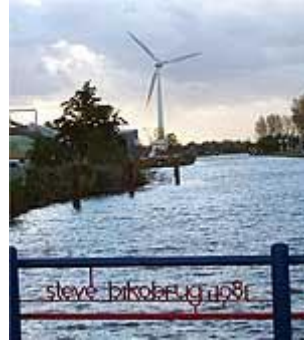
De Gouwevogel, Gouda Sinds 2000 Enercon (600 kW) Wiekdiameter: 44 m Ashoogte: 47 m Verwachte jaaropbrengst: 1.000.000 kWh
